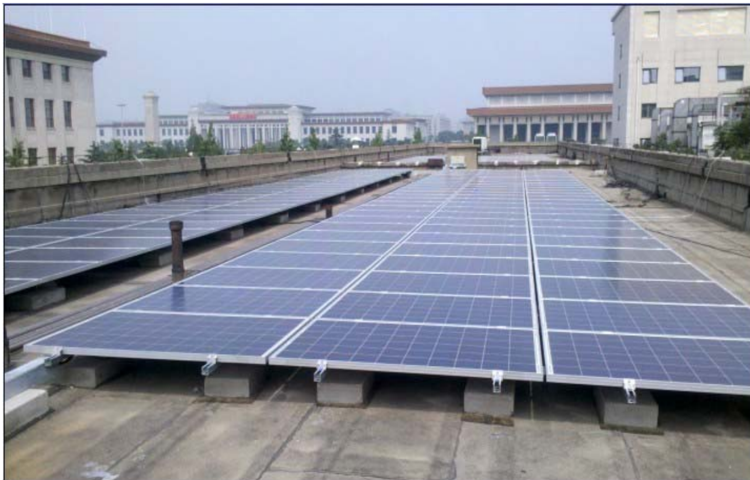
人民大会堂屋顶分布式光伏发电系统
